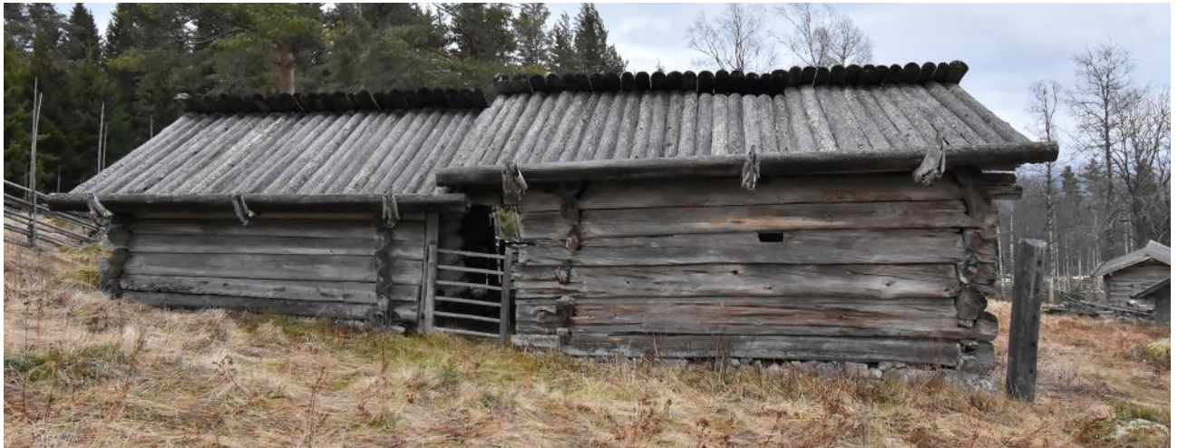
Eldhus (höger) och mjölkbod (vänster) med svalen mellan dem. Husgrupp nr 2.
