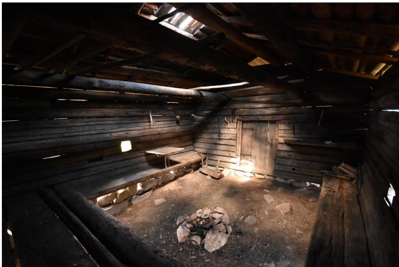
Eldhus med lavar (bänkar) längs tre sidor och gluggar mitt på väggen, samt härd mitt på golvet och en ljore rakt ovanför, det vill säga en rököppning. Husgrupp nr 11.
