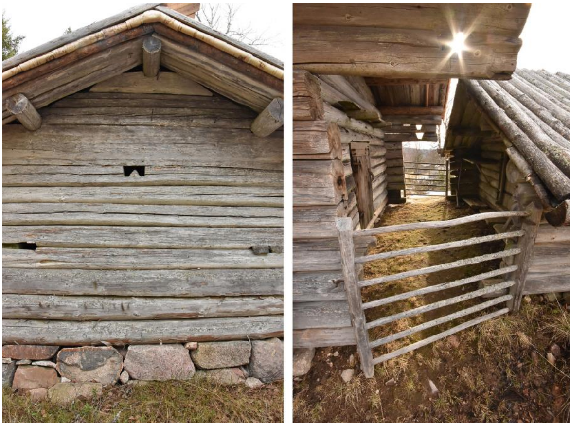
W-fönster vid husgrupp nr 10, samt svale vid husgrupp nr 13.
